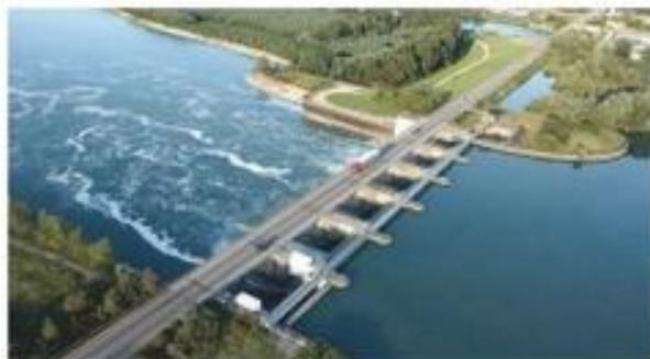
Во время приливов водохранилище станции (или устье реки) наполняется водой. Водяные потоки проходят через узкие ниши плотины и создают высокое давление. Под давлением столба воды лопасти гидротурбины начинают вращаться и вращают соединённый с ней ротор генератора, который вырабатывает электрический ток. С началом отлива вода покидает бассейн и вновь проходит через плотину, приводя в движение лопасти турбин.
