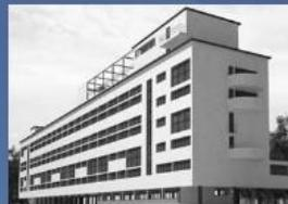
Модульная система может находиться в постоянном видоизменении, наращивании, трансформации (жилой дом Наркомфина основан на типовом модуле жилой ячейки)
