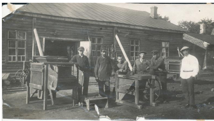
Рис.1. Новое оборудование производственных мастерских
